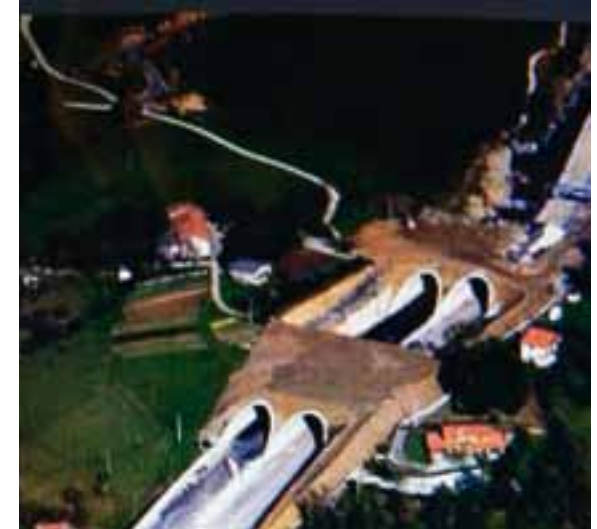
Figura 93 Y Vasca: Tren de Alta Velocidad (TAV) «Trazado en construcción» (Ezkiio-Itsaso)
